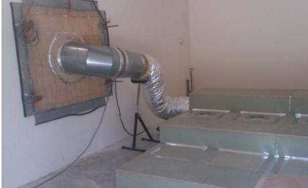
Figure 1 Raccordement du conduit aéraulique aux gradins
